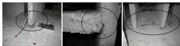
شکل (۵): نحوه خرابی در اتصال دیوار به فنداسیون، اتصالات دال به دیوار و دال طبقه اول در نمونه‌های آزمایشگاهی.
