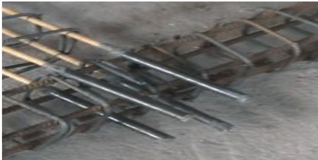
شکل ۸. میلگردهای GFRP با اتصال دهندهها قبل از قالببندی Fig. 8. GFRP rebars and connectors before formatting
