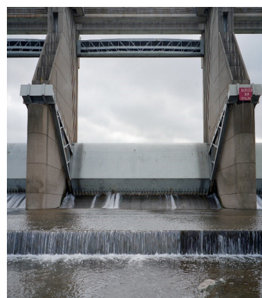
شکل ۲. تصاویر دریاچه قطاعی به همراه آستانه در سد اندرسن (الف) و در سد مکاپاین (ب)
